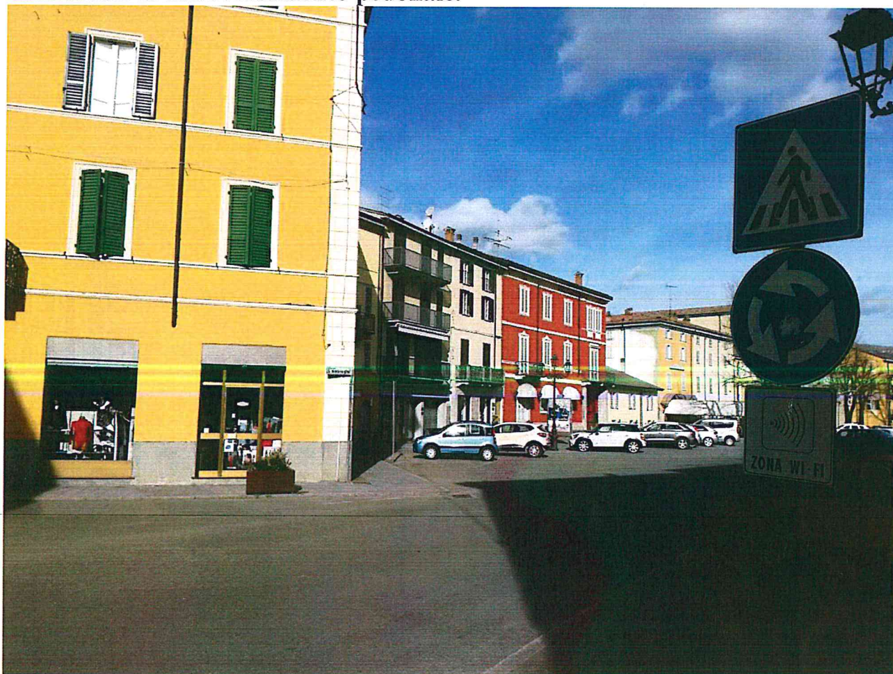
FOTO n. 9 Piazza Colombo verso Piazza S. Ambrogio manca segnaletica orizzontale di attraversamento pedonale.
