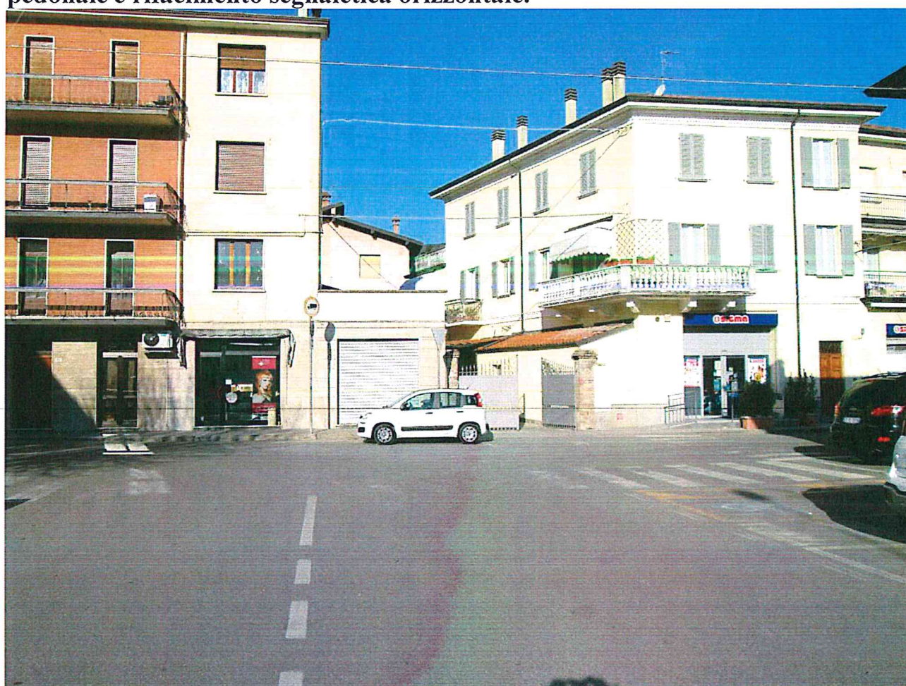
FOTO N.13- Via 24 Maggio integrare segnaletica verticale di attraversamento pedonale e rifacimento segnaletica orizzontale.
