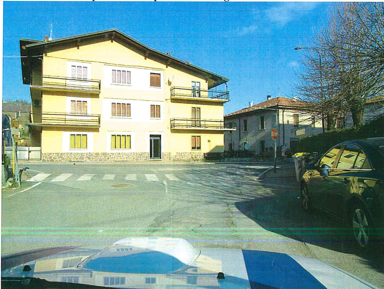
FOTO N. 19- Via De Amicis, integrare con segnaletica verificare l'attraversamento pedonale e ripristinare la segnaletica orizzontale.
